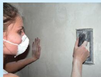
Шлифовка поверхности
