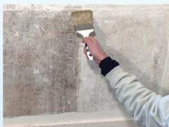
Грунтовка оштукатуренных стен
