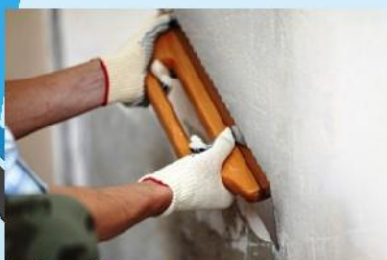
Разглаживание шпатлёвки
