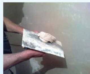
Нанесение стартовой шпатлёвки
