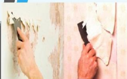
Отчистка старой отделки
